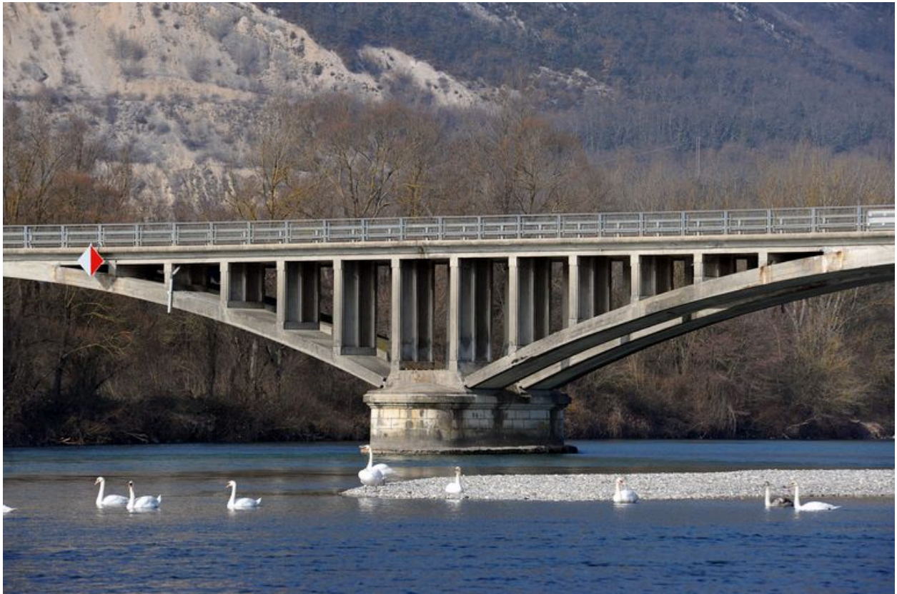
Vue partielle, pile, face aval (depuis la rive gauche)
