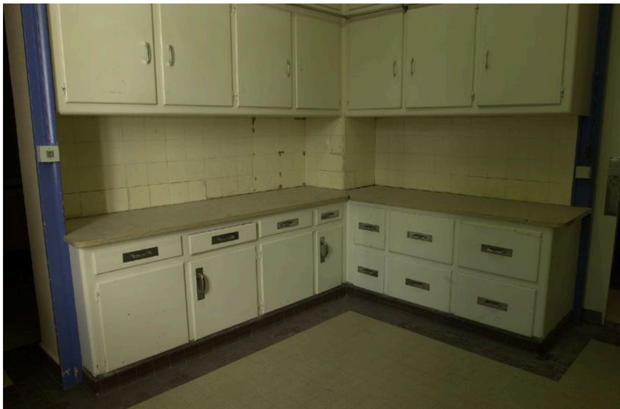
Rez-de-chaussée : vue des meubles de la cuisine
