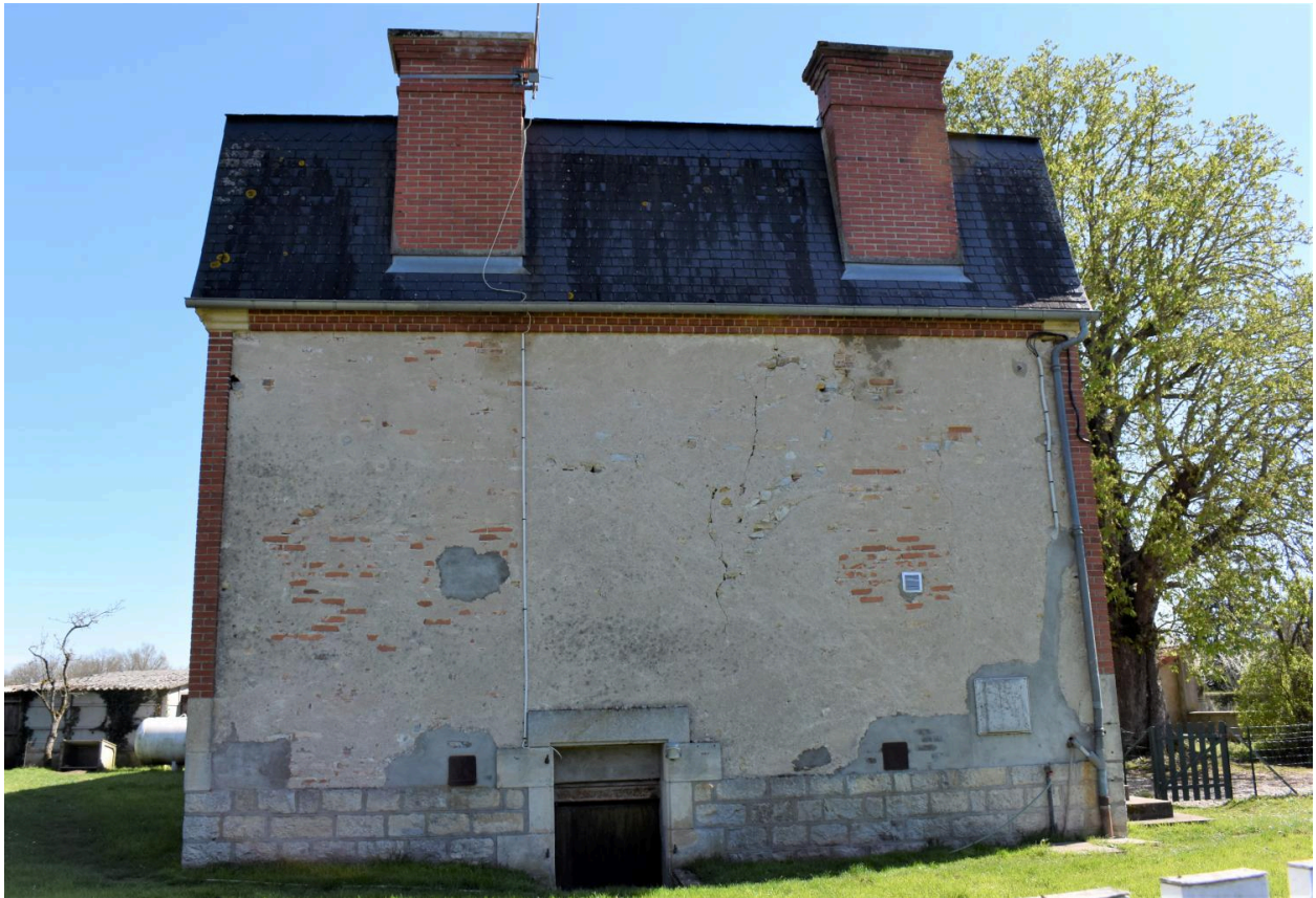
Vue de la façade nord
