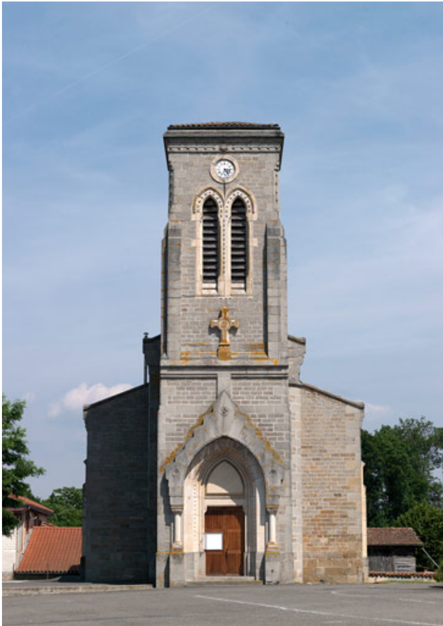
Vue d'ensemble de la façade occidentale.
