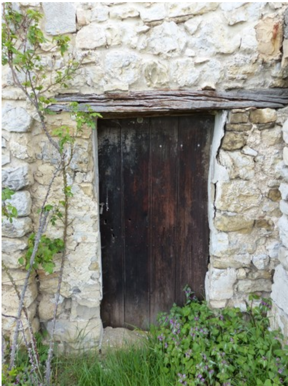
Pignon sud, premier niveau. Porte est.
