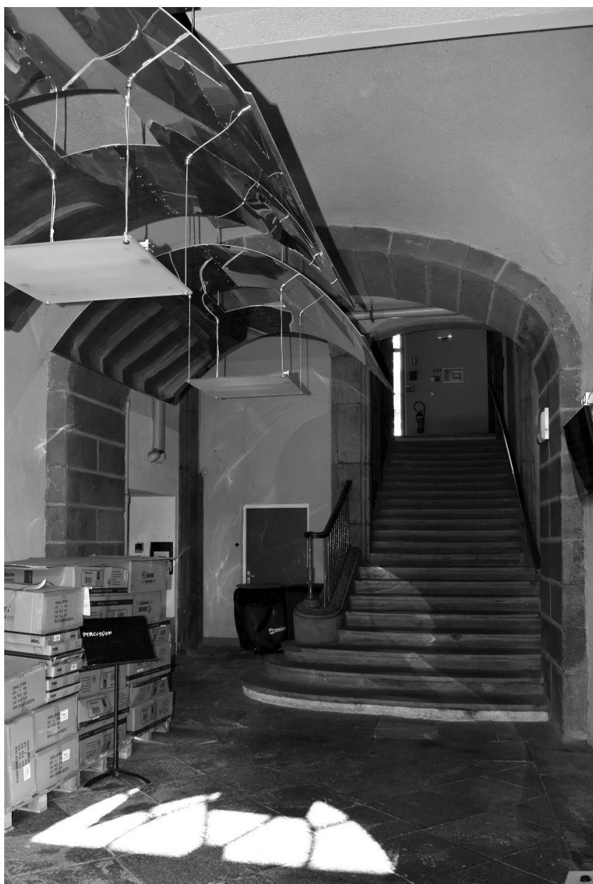
Escalier D : départ de l'escalier niveau étage de soubassement
