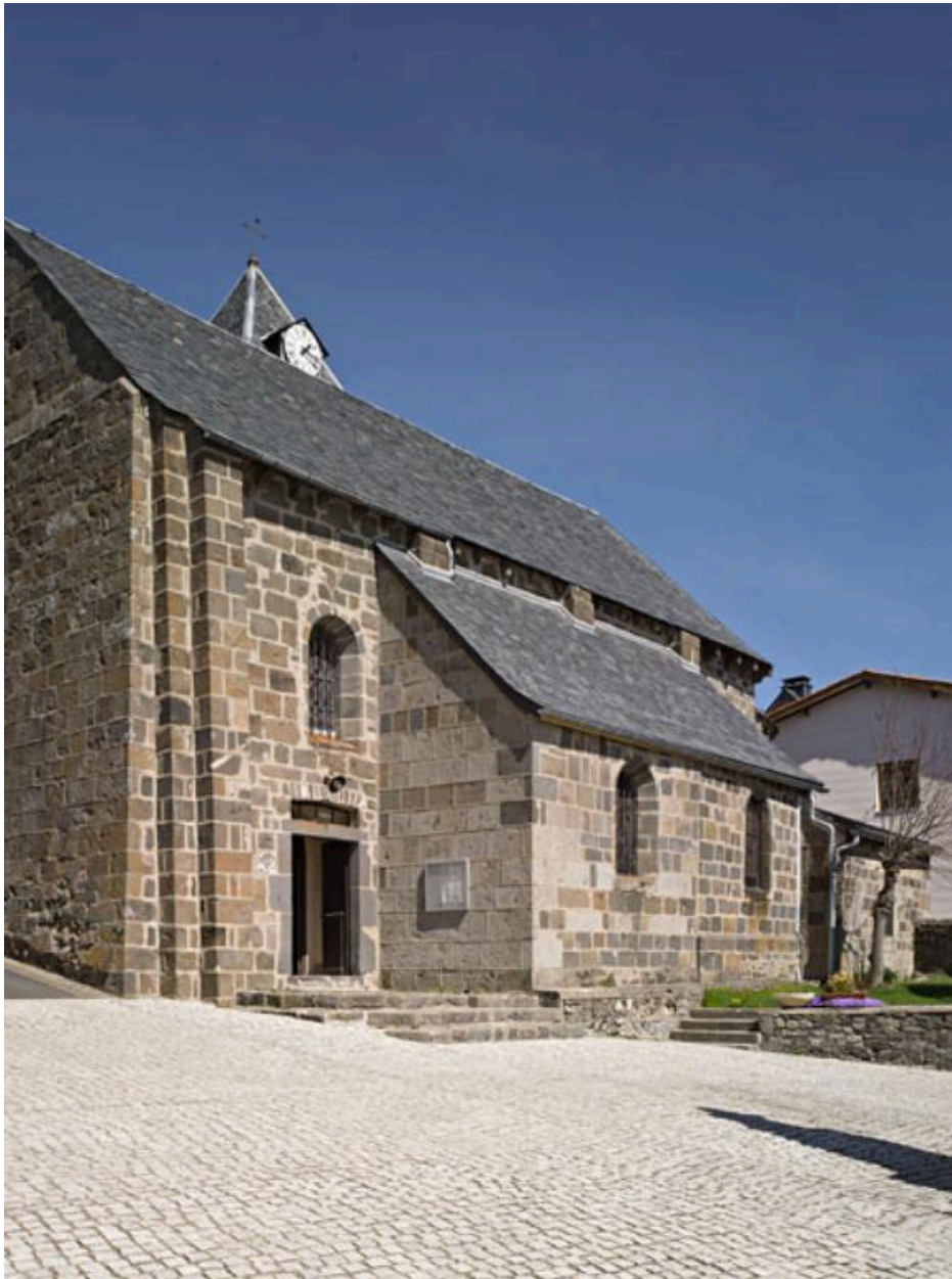
Vue générale au sud.
