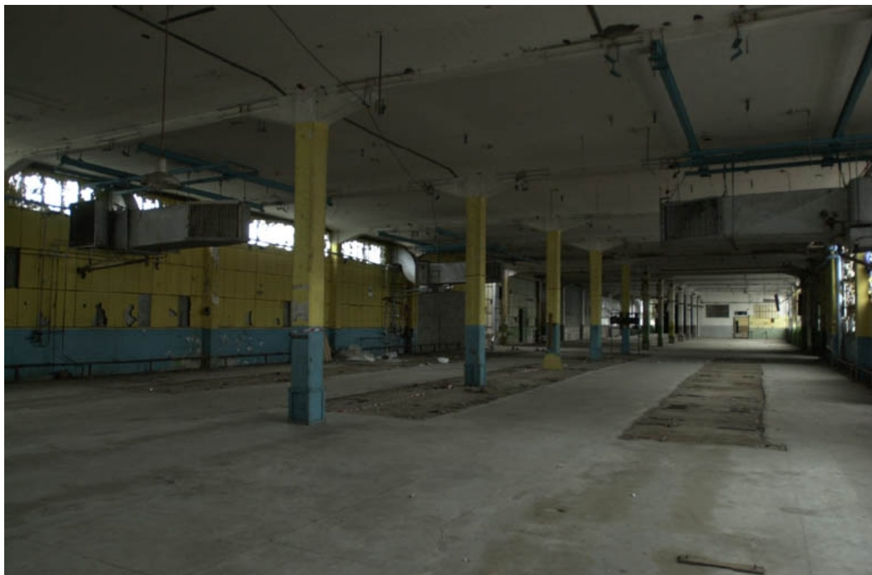
Vue des espaces intérieurs des ateliers : série de poteaux poutres en béton
