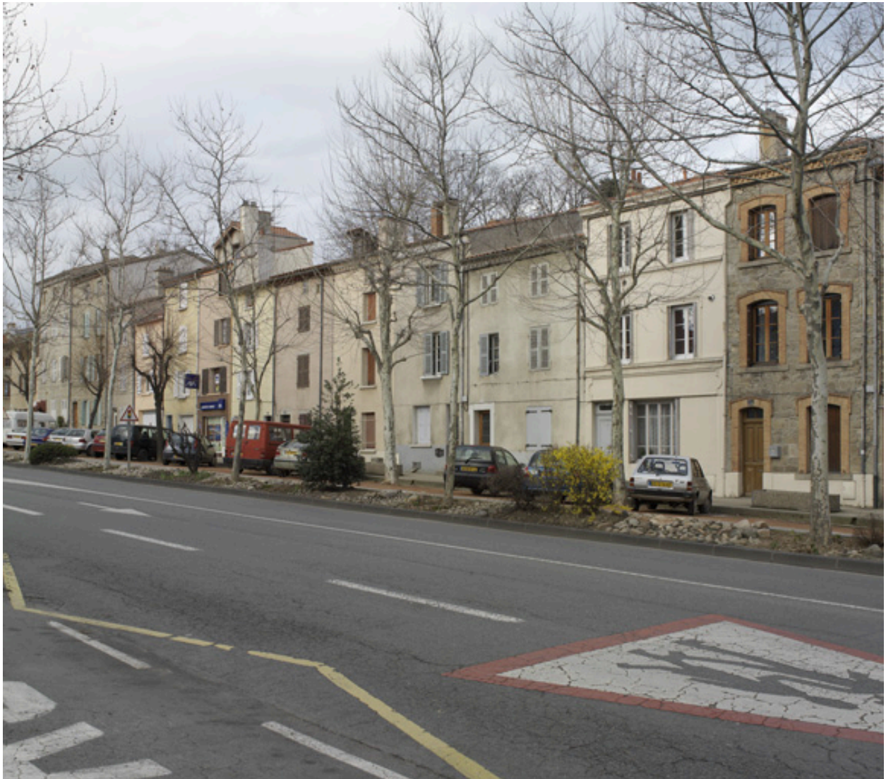
Vue de situation (2e maison, à partir de la droite).
