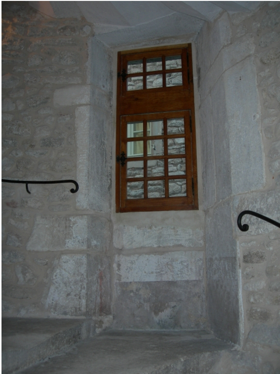
Baie prenant jour sur la rue, entre le 1er et le 2e étage de l'escalier en vis.
