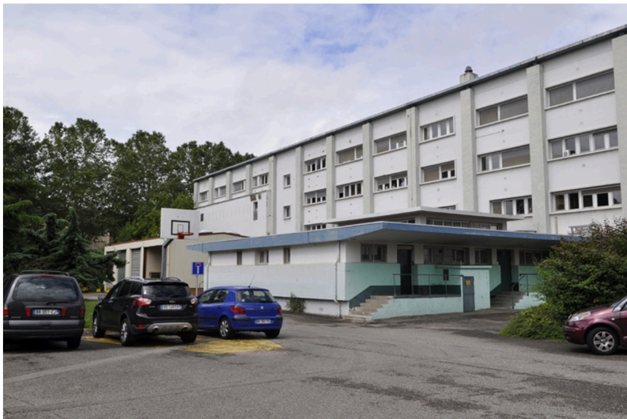
Bâtiment affecté au logement, façade sud.
