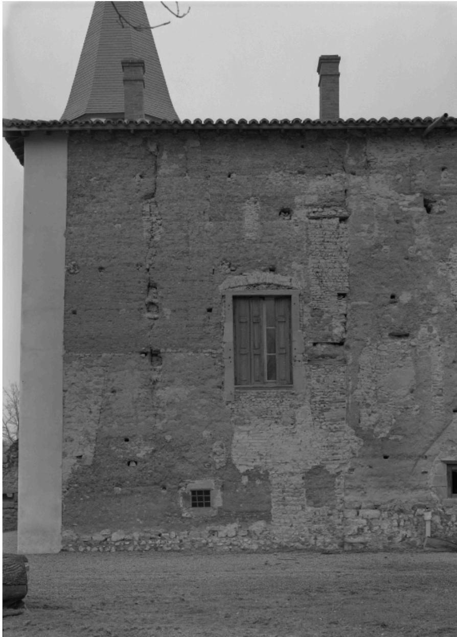
Façade sur jardin du corps de galerie, après décroûtage : détail de la partie nord en moellons accotée au corps primitif en pisé.
