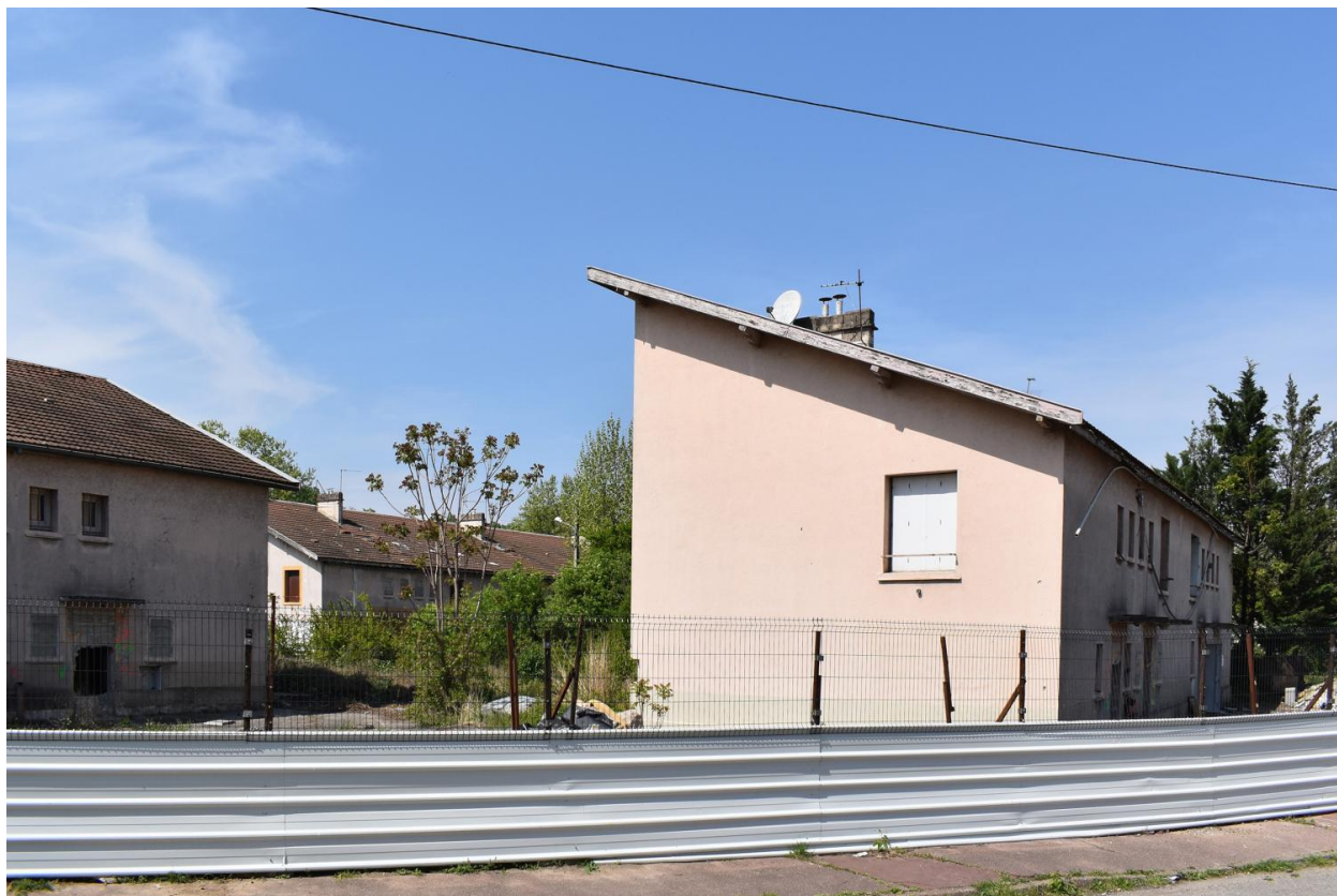
Cité ouvrière P.L.M. dite Coblod - vue depuis la rue Félix Brun
