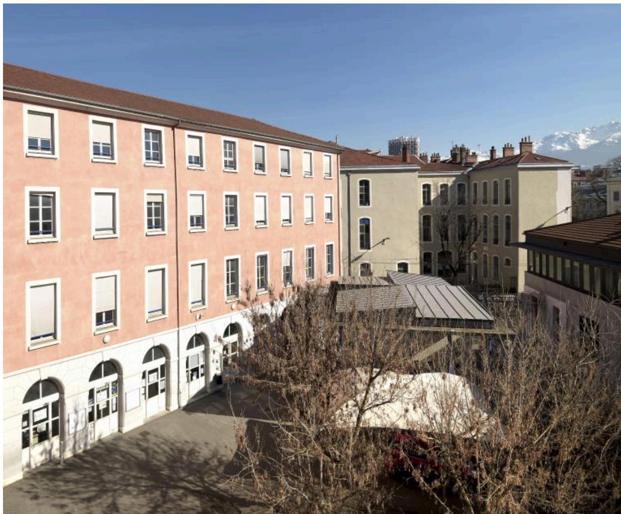
Corps de bâtiment 19e, élévation postérieure depuis l'ouest
