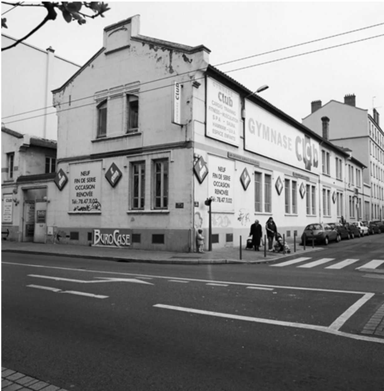
Vue de l'angle sud
