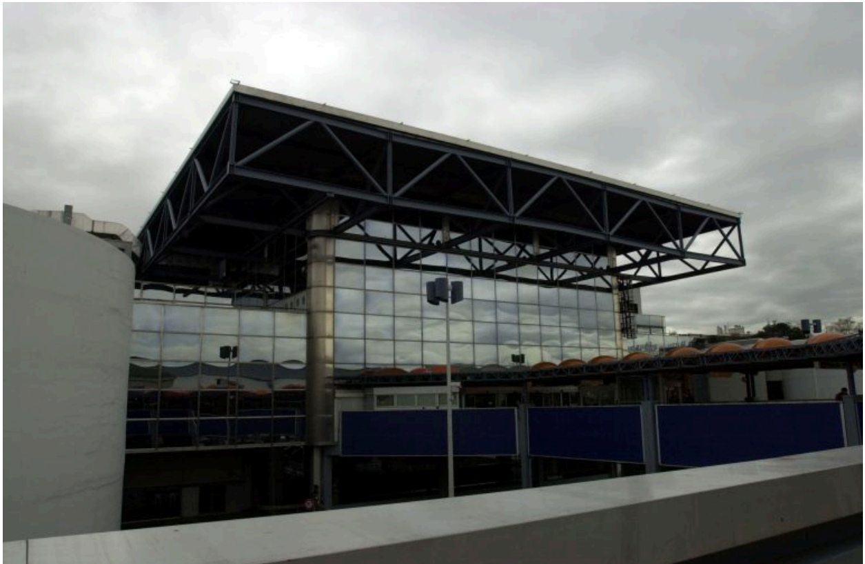
Elévation sud du centre commercial et amorce de la passerelle
