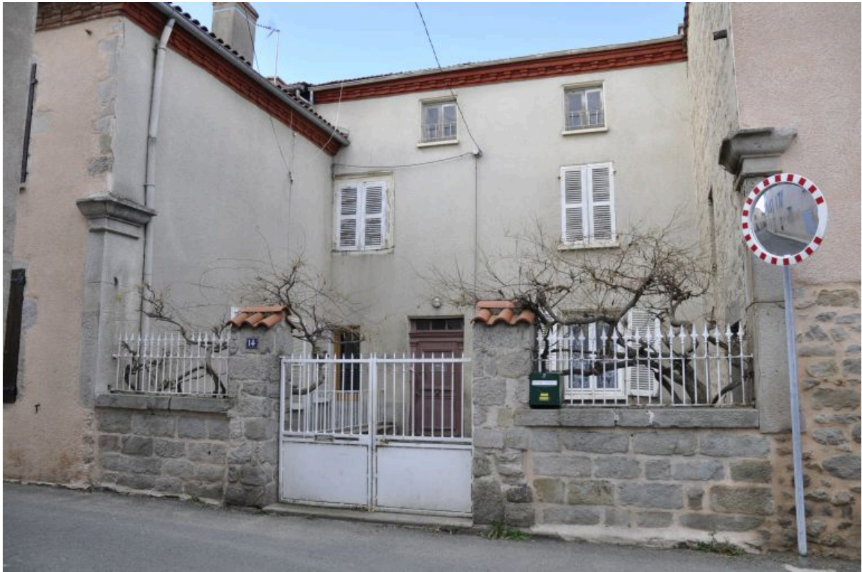
1986 AE 794. 14 rue Centrale. Ancien presbytère, vue d'ensemble depuis la rue.
