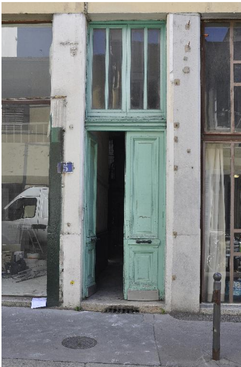
Vue rapprochée de la porte d'entrée
