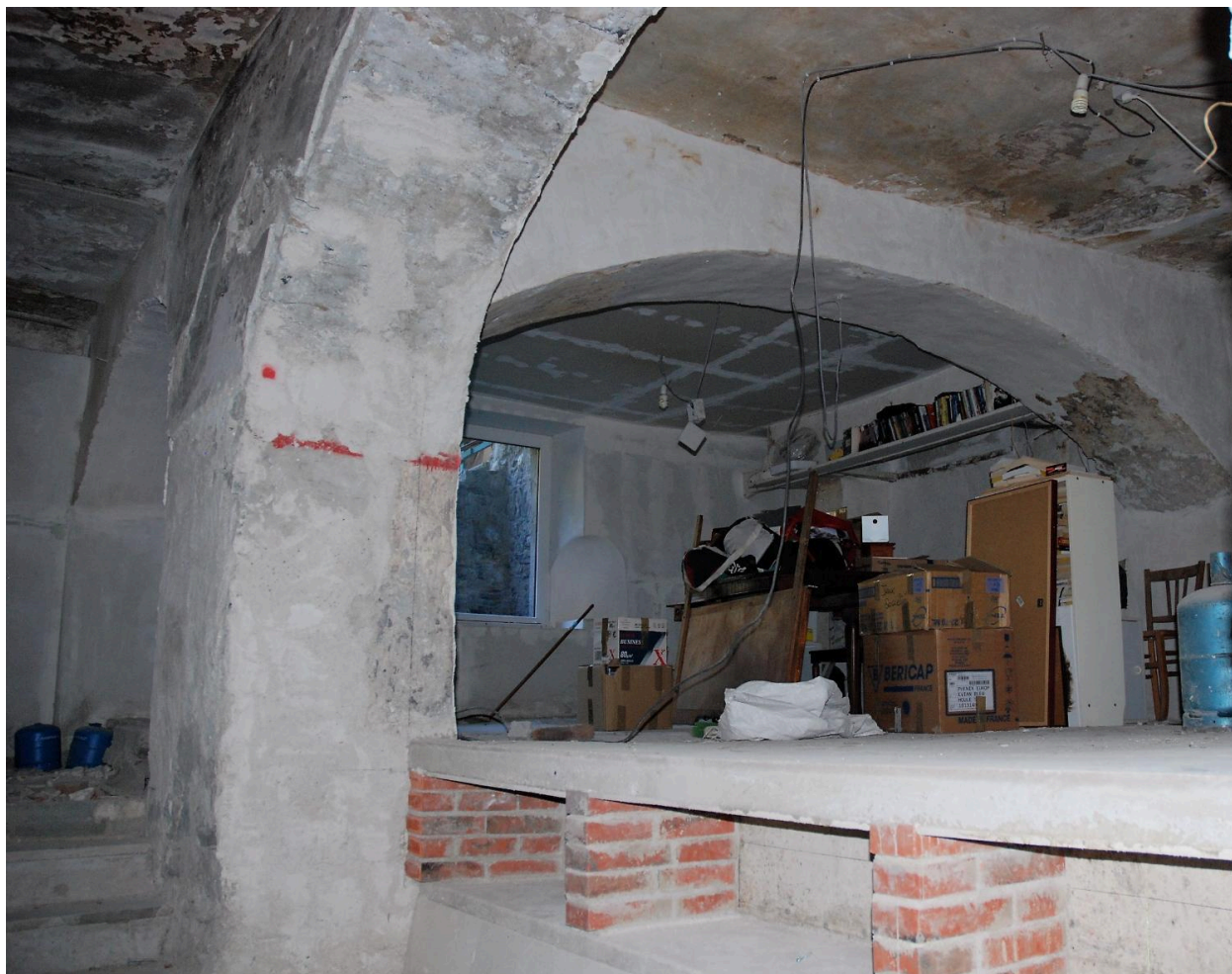
Maison, immeuble, 100 rue Louis Blanc-Pinget (2018 E1 1797). Vue intérieure du rez-de-chaussée. Extrémité nord de la travée est.
