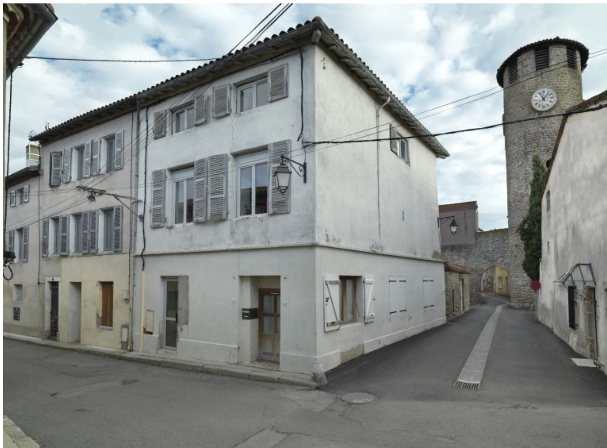
Vue générale sur rue
