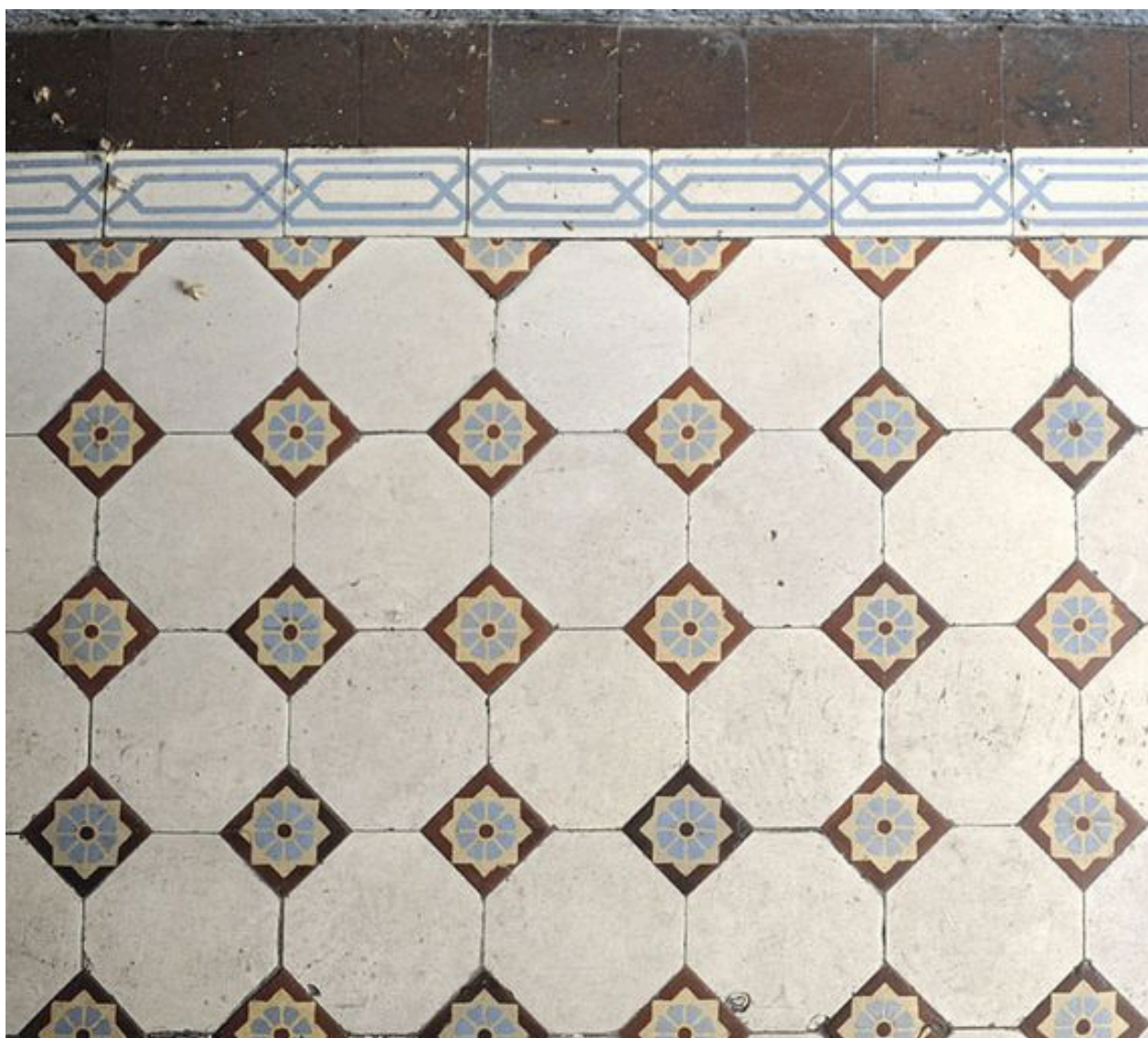
Détail du carrelage du vestibule
