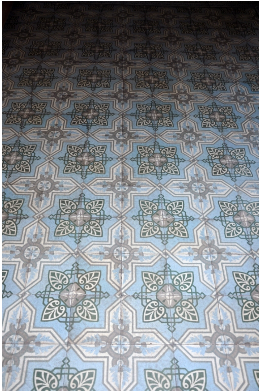
Carrelage du palier du 1er étage
