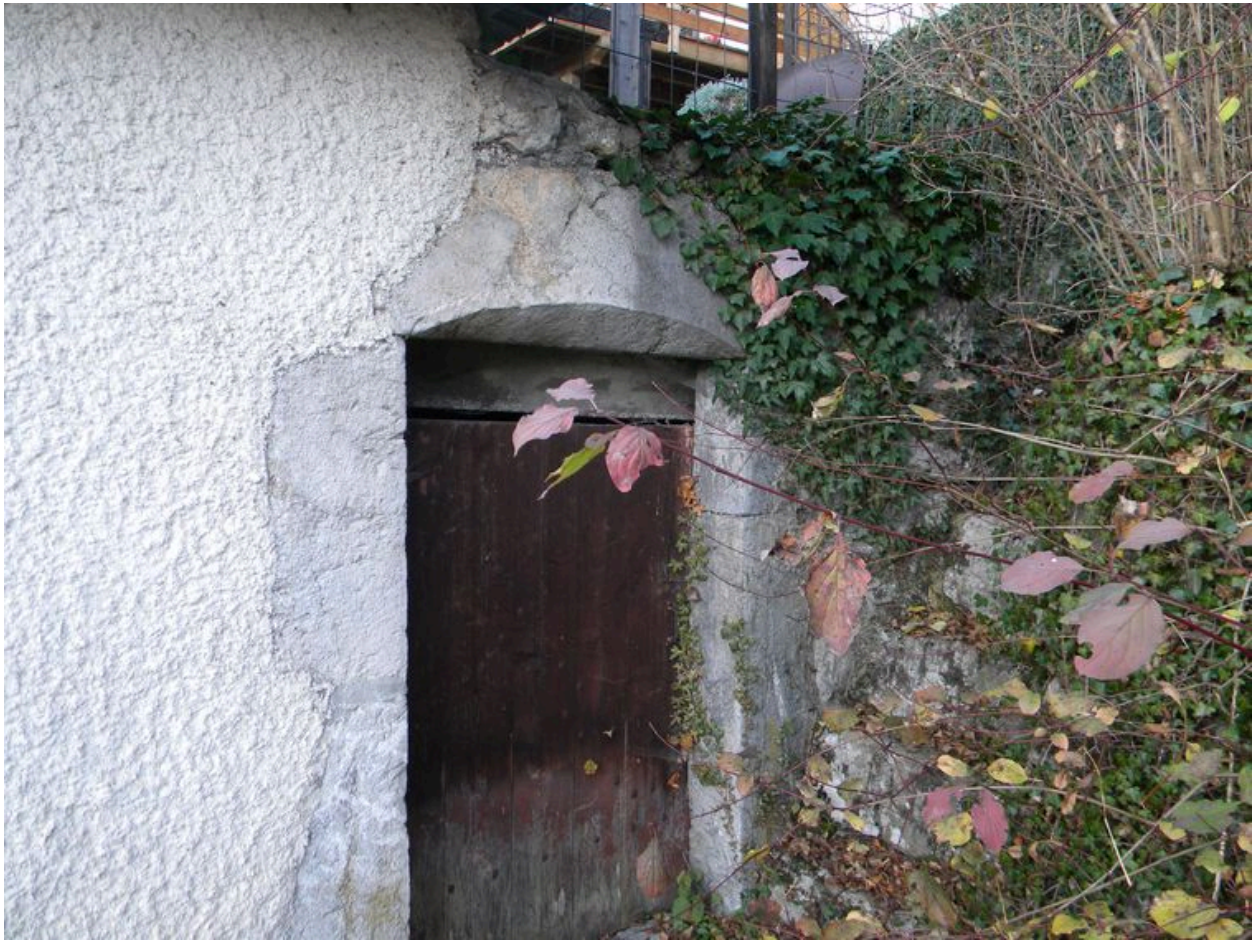
Vue d'une porte de cave à linteau délardé.
