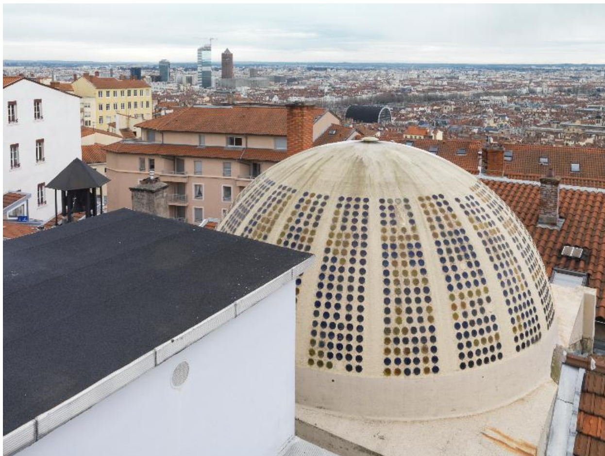
Vue du dôme, depuis la terrasse du bâtiment conventuel
