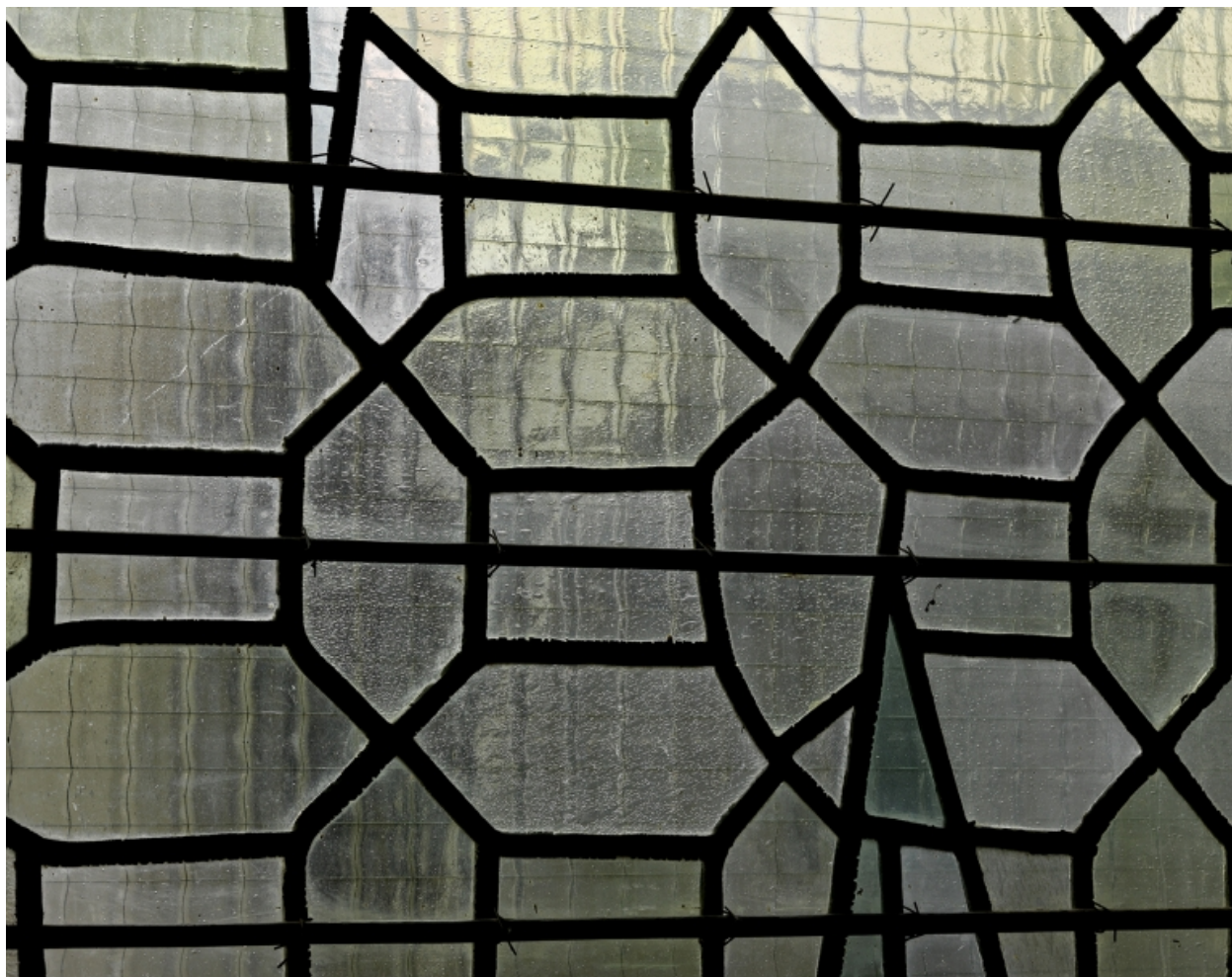
Verrières du mur ouest. Détail
