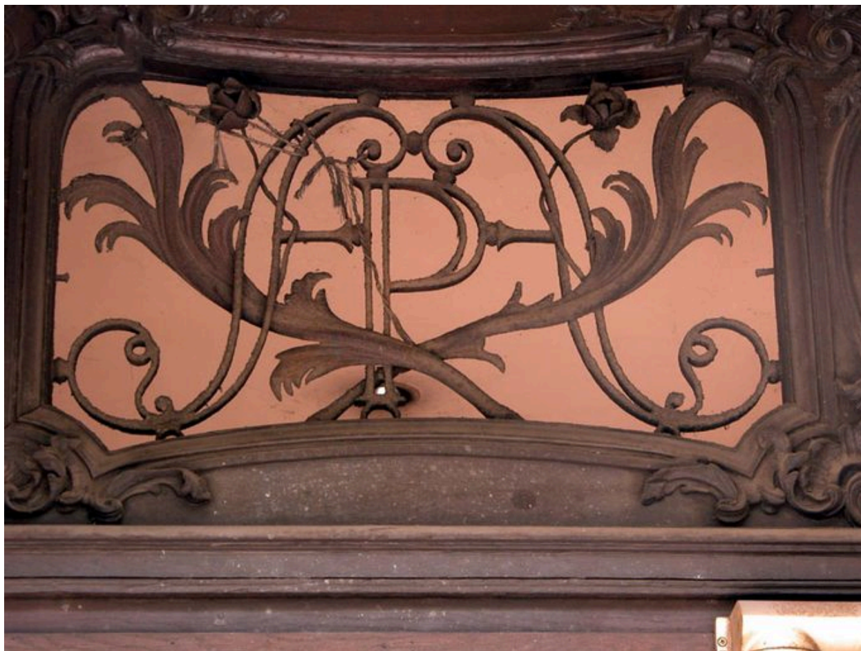
Détail de l'imposte, quai Saint-Antoine
