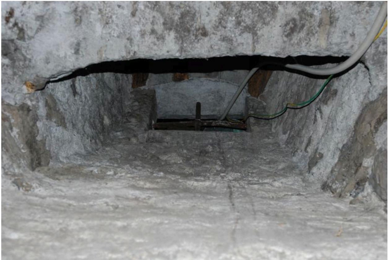
Sous-sol, première cave voûtée en berceau plein-cintre, vue du soupirail contre le mur est.
