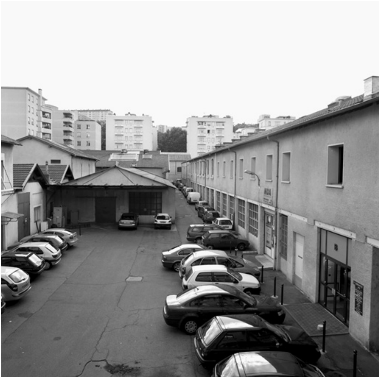
Vue nord de la cour intérieure
