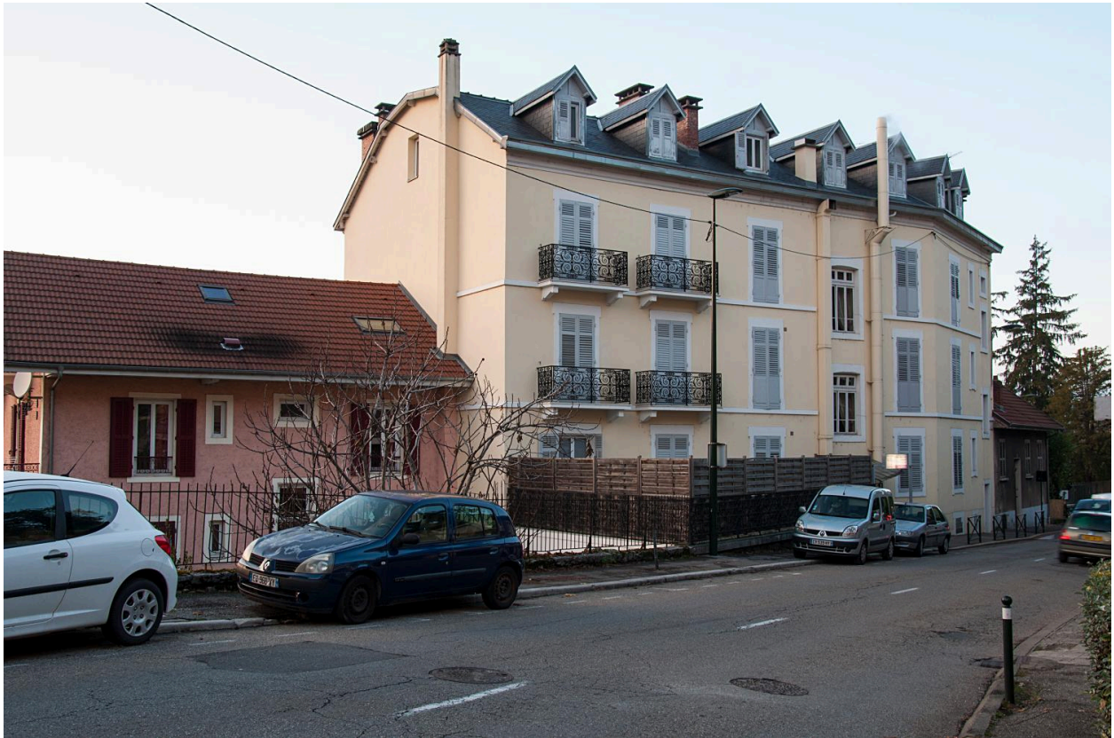
Façade est, boulevard des Côtes
