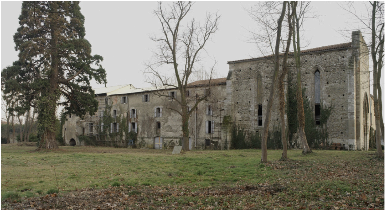
Vue d'ensemble latérale gauche des bâtiments du site de Sainte-Eugénie.
