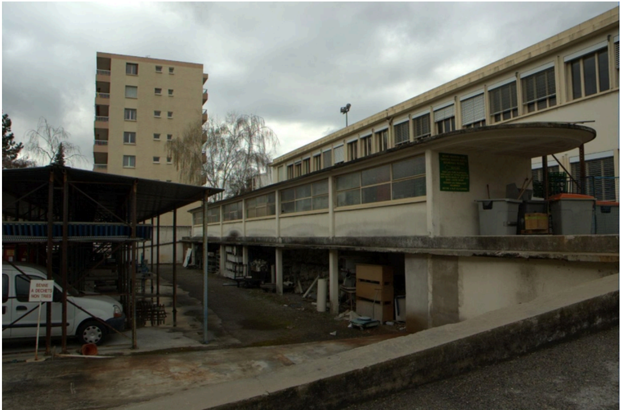
Espace technique de l'usine
