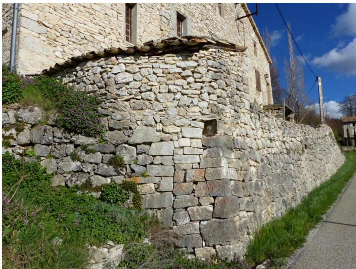
Mur de soutènement de la cour, angle sud-ouest.
