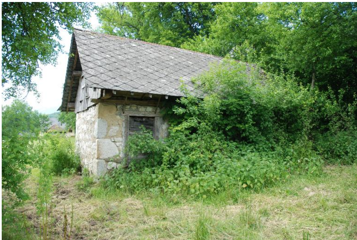
Vue d'ensemble du bâtiment de trois quart avant droit.
