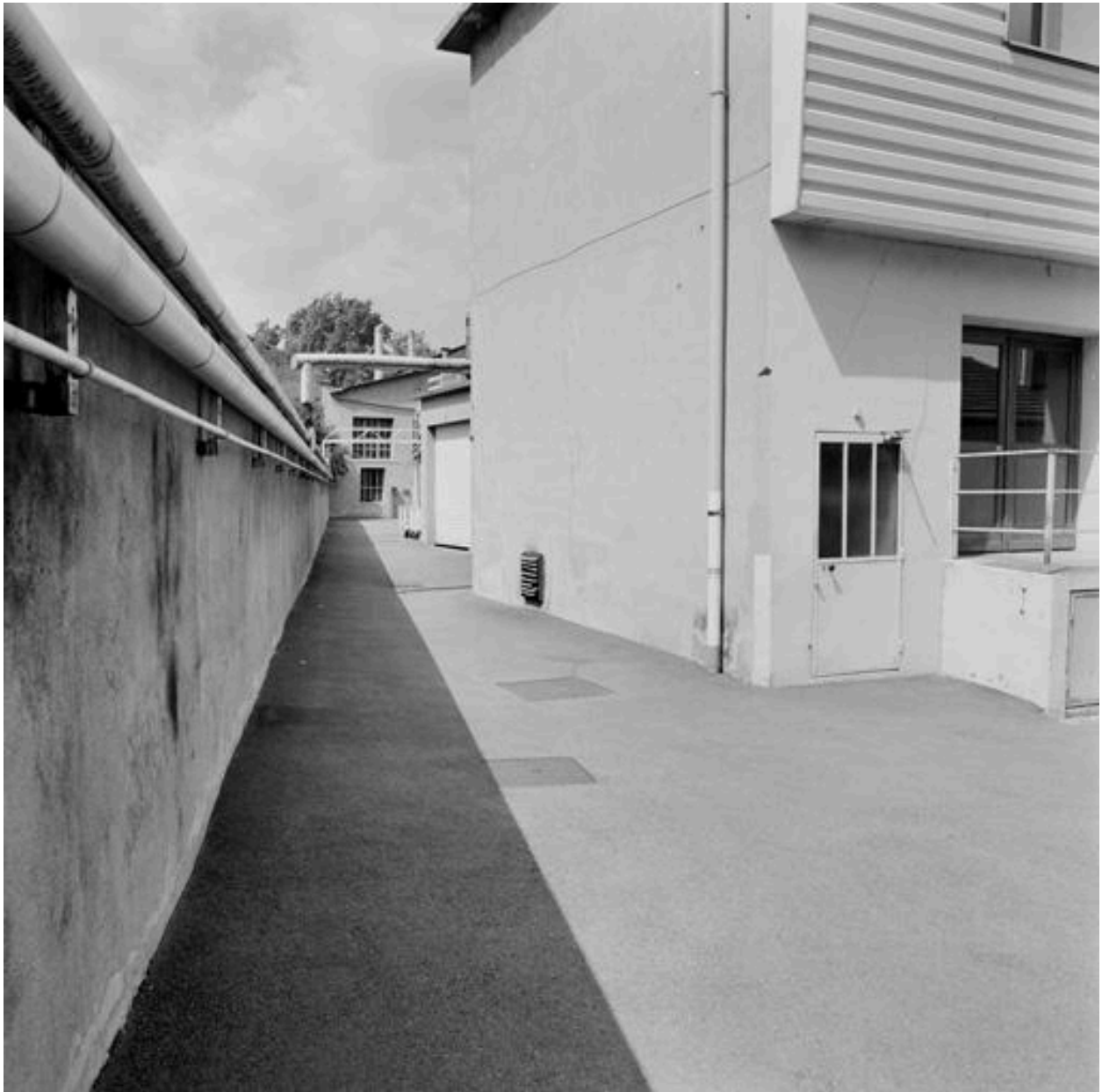
Détail circulation extérieure
