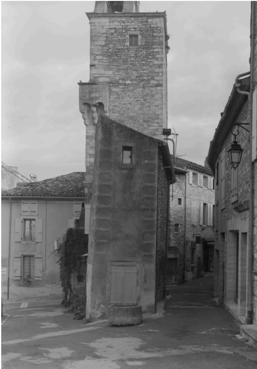
Elévation sud du beffroi.
