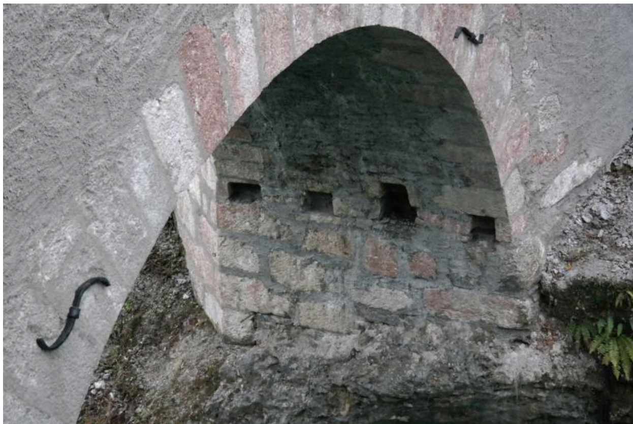
Pont d'Evian, détail voûte
