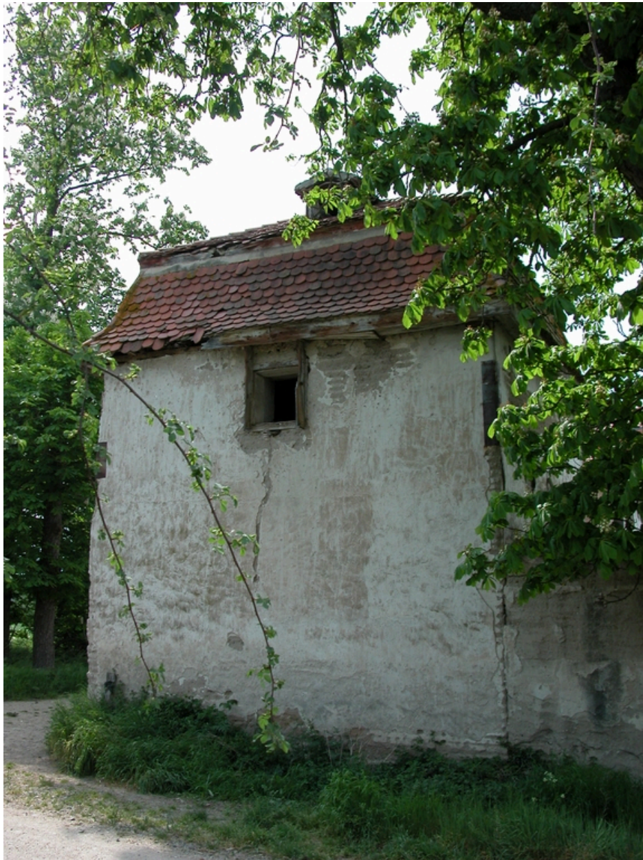
Vue du pigeonnier sud, depuis le sud-est.
