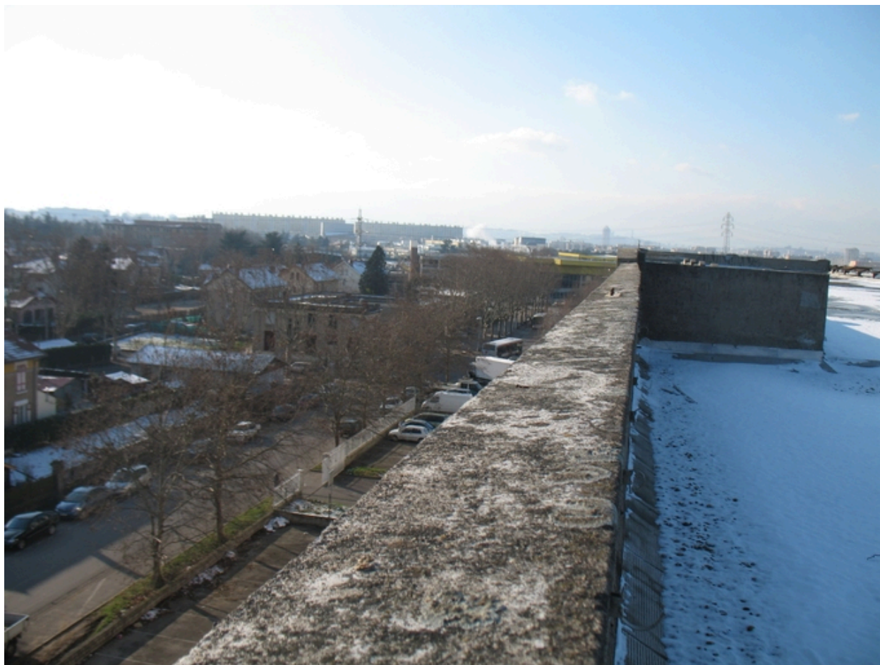
Vue du toit terrasse du bâtiment principal
