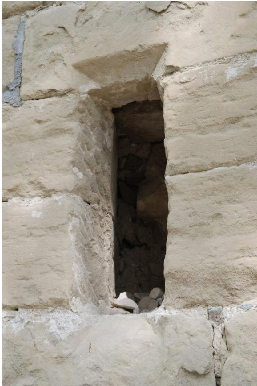
Façade ouest de la maison forte, détail d'une ouverture située à la base (ancienne meurtrière ?)
