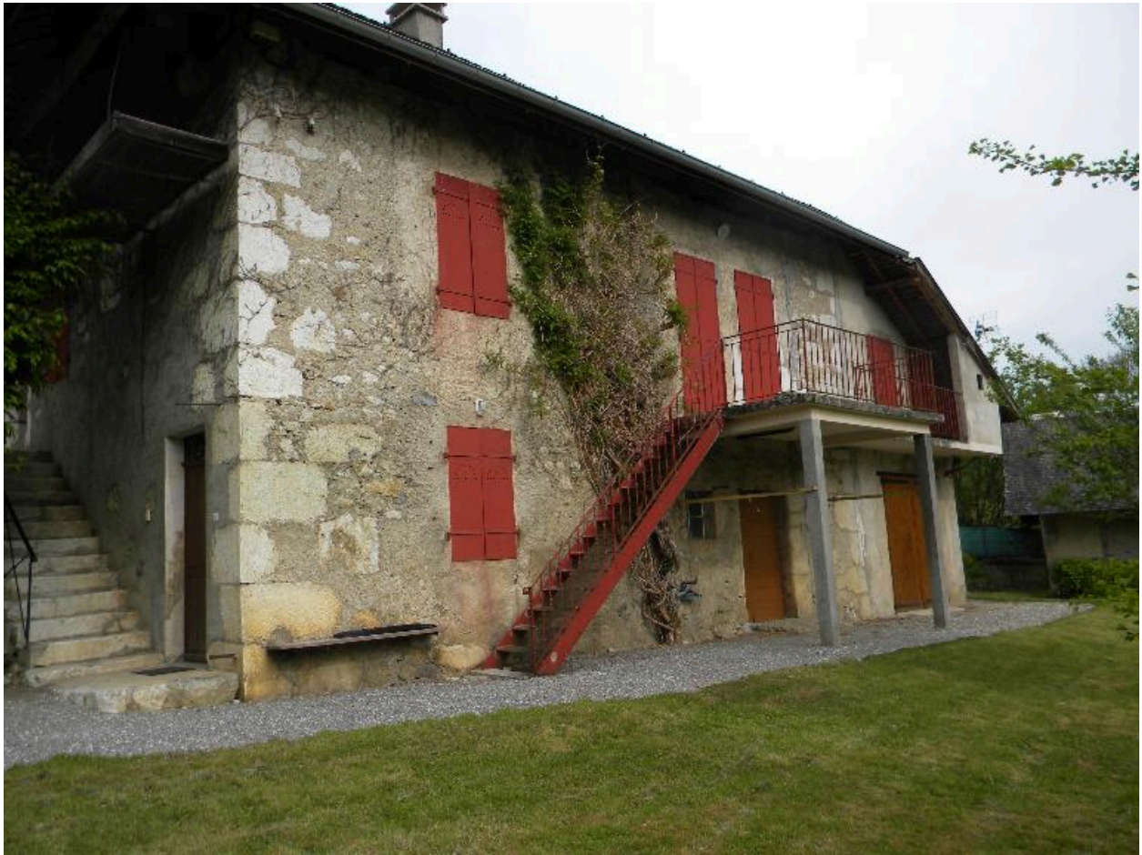
Vue du mur est.
