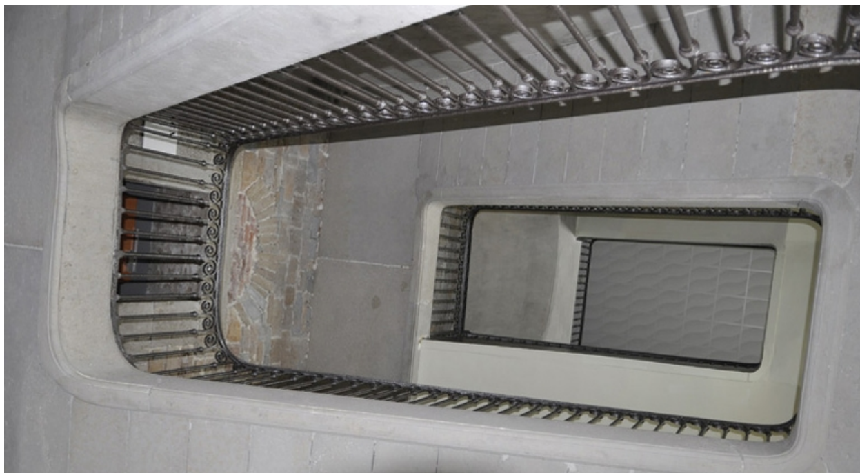
Vue de la cage de l'escalier latéral est.
