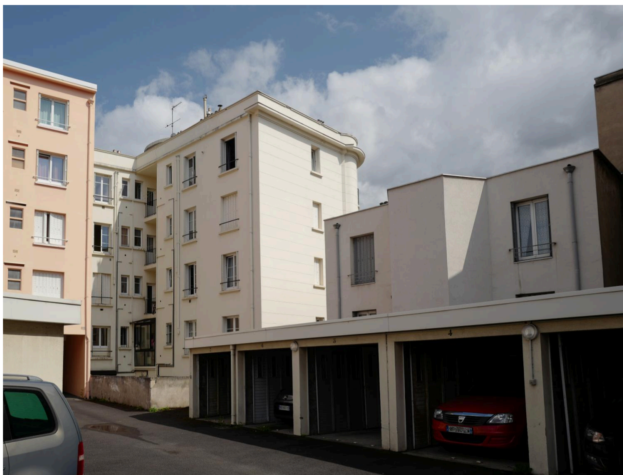
Elévations postérieures depuis la cour
