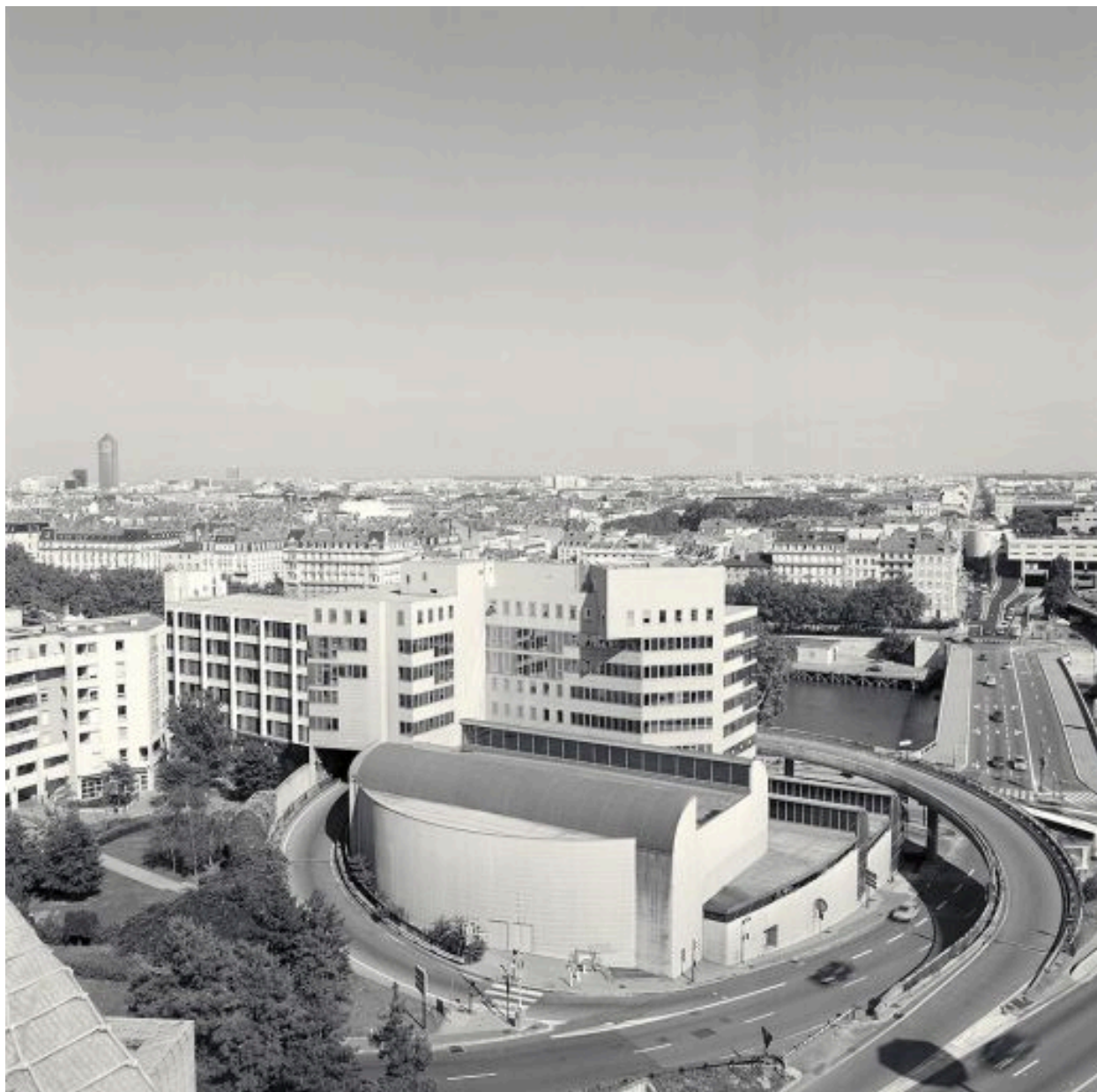
Vue du pont depuis la tour du tunnel de Fourvière à l'ouest
