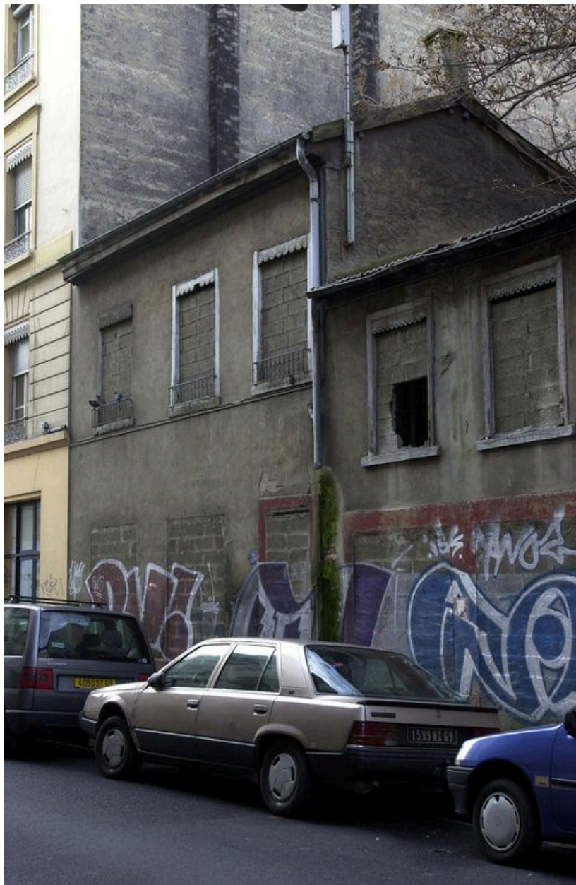
Façade principale sur rue
