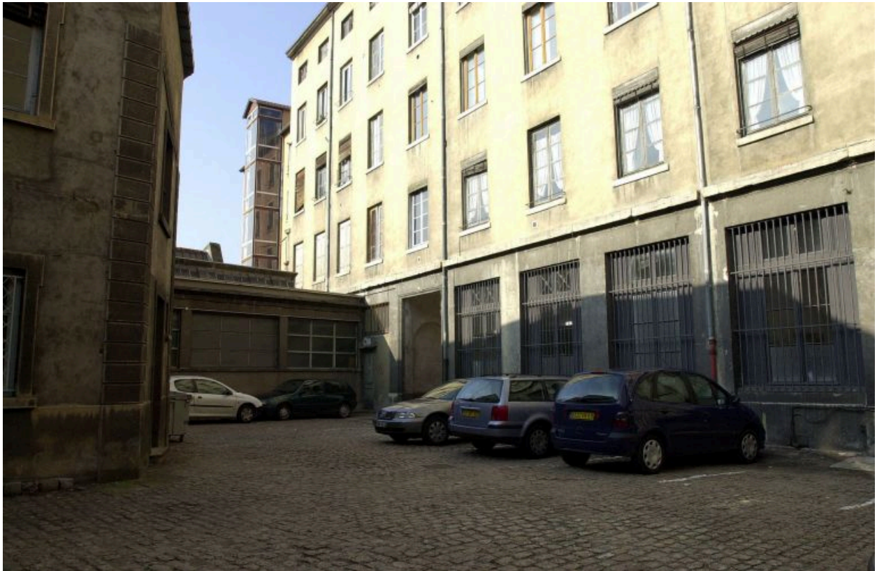
Elévation postérieure sur cour et atelier construit au sud de la cour
