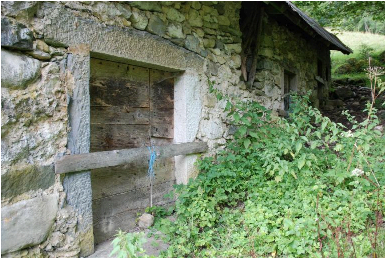
Vue de la façade principale (sud) depuis le sud-ouest : entrée de l'étable.
