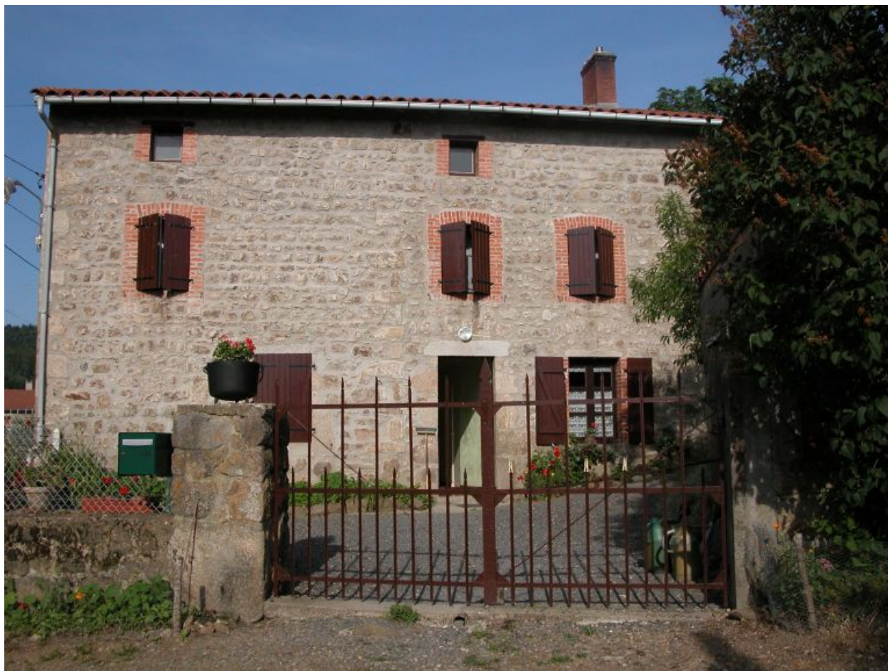
Vue d'ensemble de la façade sur cour.
