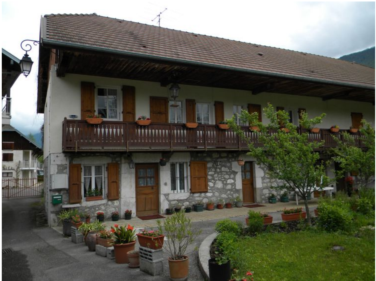
Vue de la façade sud avec la partie habitation.
