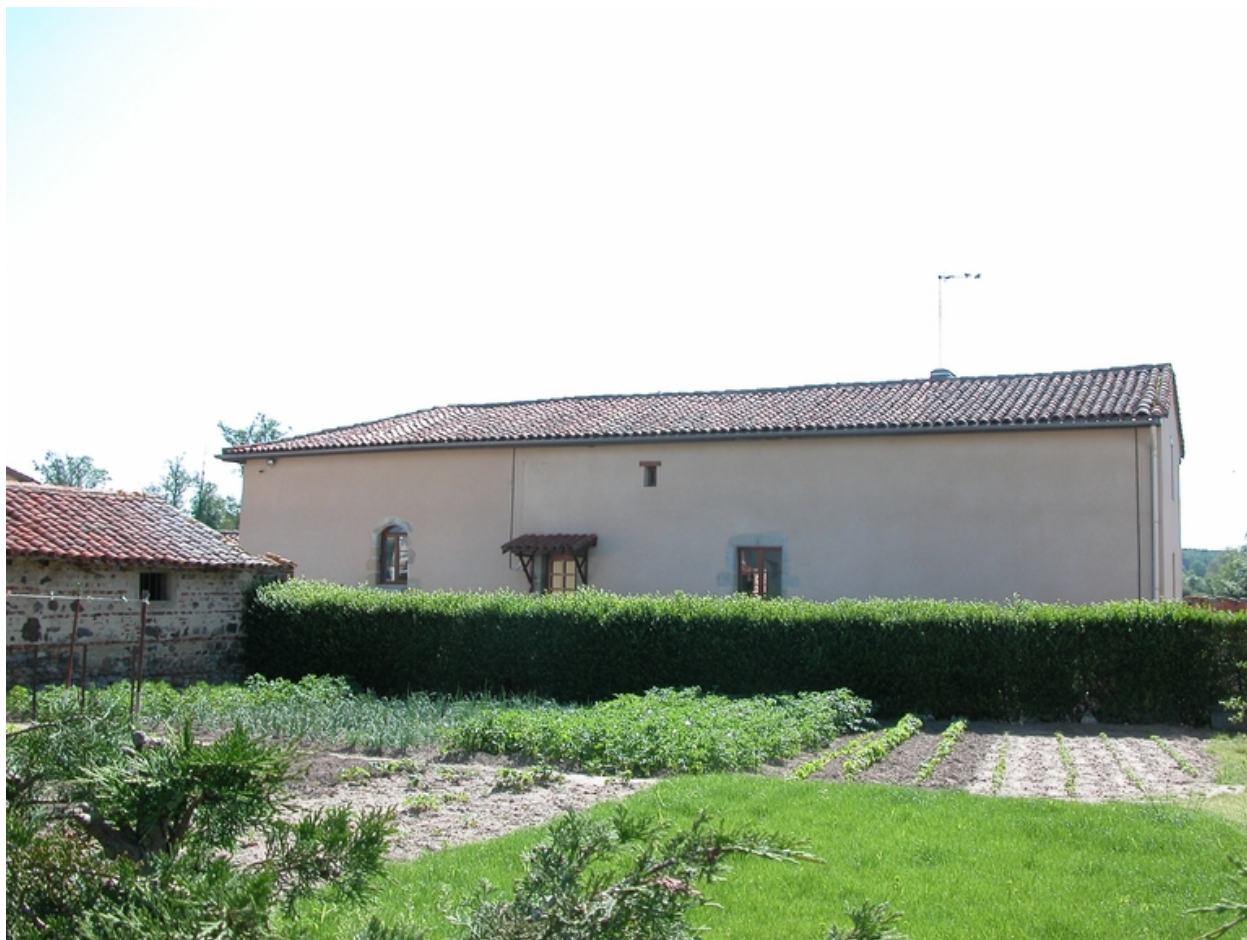
Vue de la façade ouest du logis.
