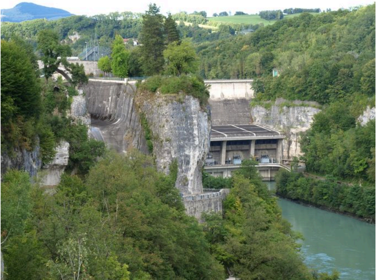
Vue générale du barrage, face amont
